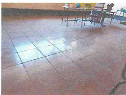
Foto 3: Se colocó el piso cerámico en la segunda aula.
