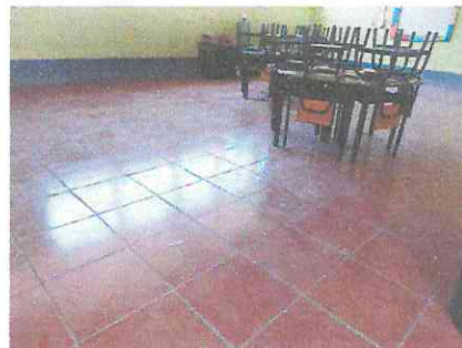
Foto 2: Se instaló el piso cerámico en la primer aula.
