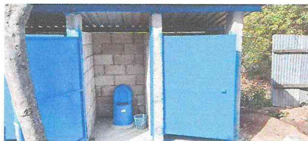
Foto 4: Se colocaron sanitarios nuevos.
