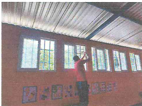
Foto 1: Se colocaron las ventanas de pvc en la 2 aulas.
