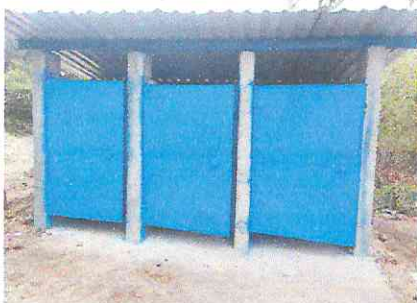
Foto 5: Terminó por completo la colocada de baños.
